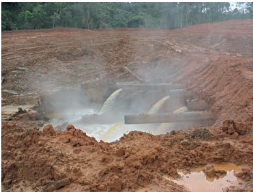
Aguas de producción de la batería de Jibarito saliendo al río Pucacungayacu, afluente del río Corrientes.
