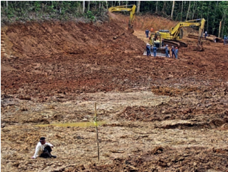
Laguna Sansochoca. Lote 1AB/192. Antes y después. Pastaza. Fuente: PUINAMUDT
